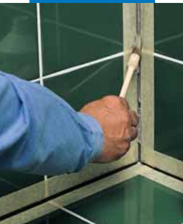
Application of Primer FD
